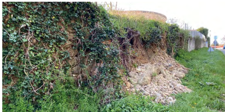
Rénovation du talus de la résidence Saint-Jude
