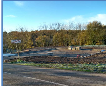
2020: Viabilisation Lotissement communal
