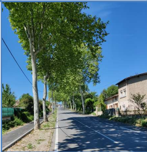
2024: Travaux de sécurisation de l'avenue du 19 mars 1962
