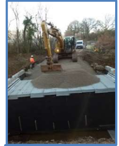
2023: Reconstruction pont d'En Caillaouet
