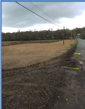
2020: Création d'un parking au stade
