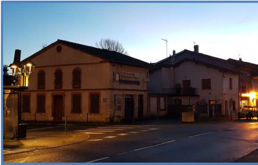
2024: Passage en LED de l'ensemble des points lumineux
