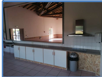
2021: Rénovations cuisines salles des fêtes
