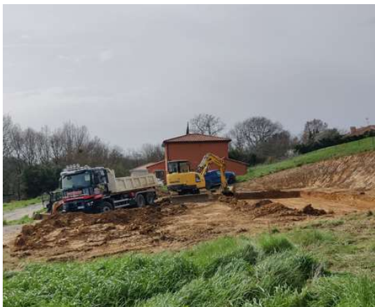
Dernière construction en cours sur lot n°1
