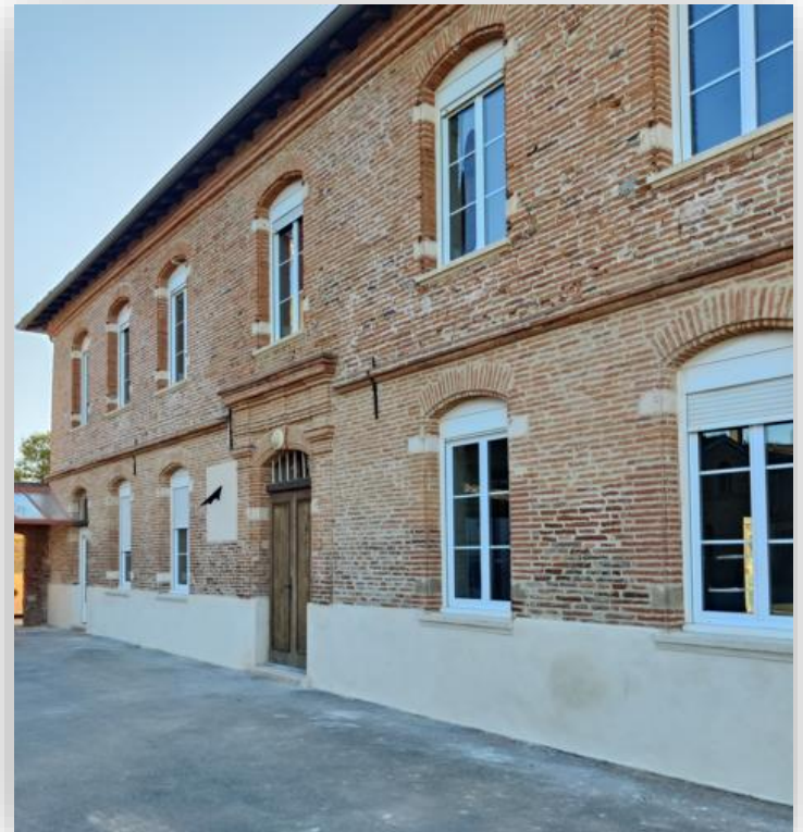
Après les travaux
