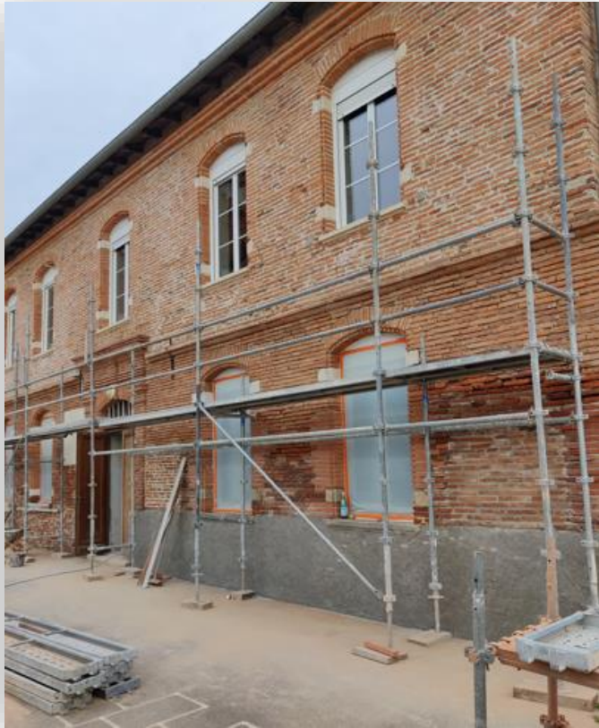
Pendant les travaux
