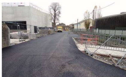
Enrobé rue du stade à Martres-Tolosane
