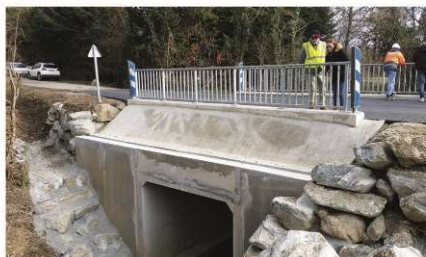
Remplacement de l'ouvrage de Sainte-Foy-de-Peyrolières
