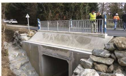
Remplacement de l'ouvrage de Sainte-Foy-de-Peyrolières
