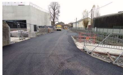
Enrobé rue du stade à Martres-Tolosane
