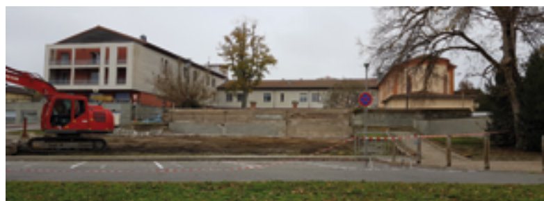
Démolition de l'ancien atelier du service technique
