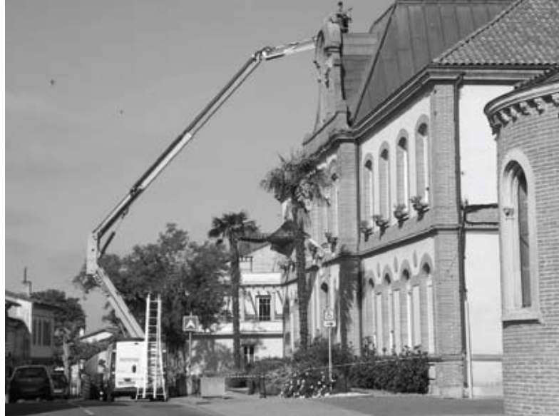
Entretien des bâtiments municipaux
