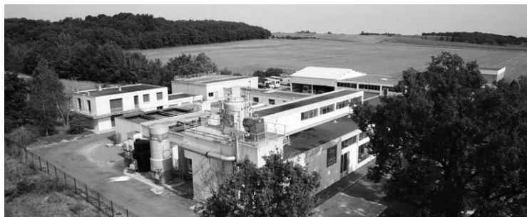
Usine de production d'eau potable de Lherm
