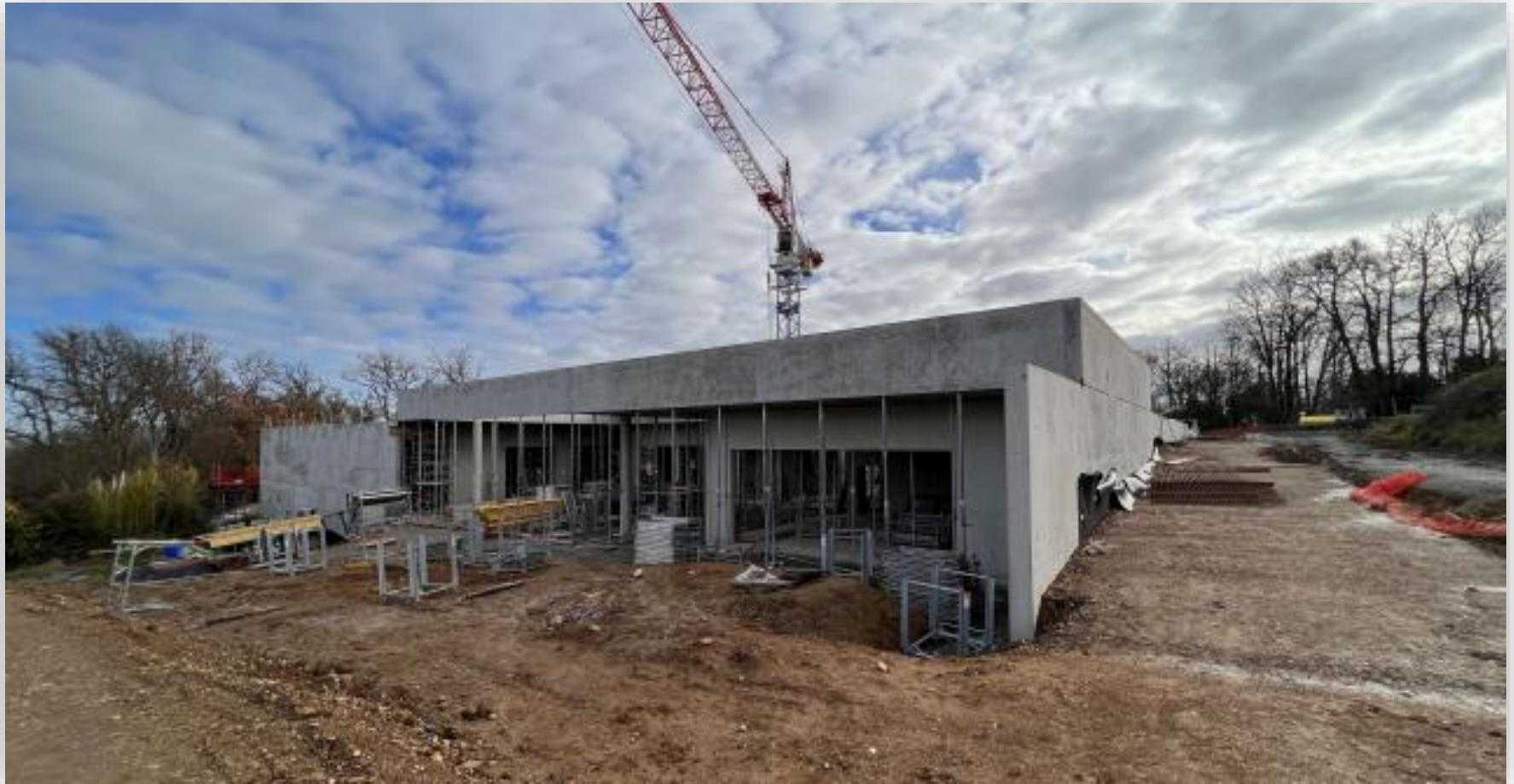
Chantier complexe scolaire en janvier 2022
