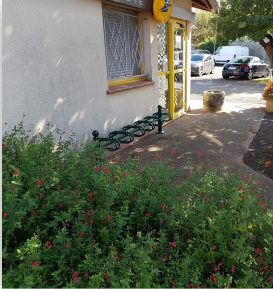
Installation garage à vélos
