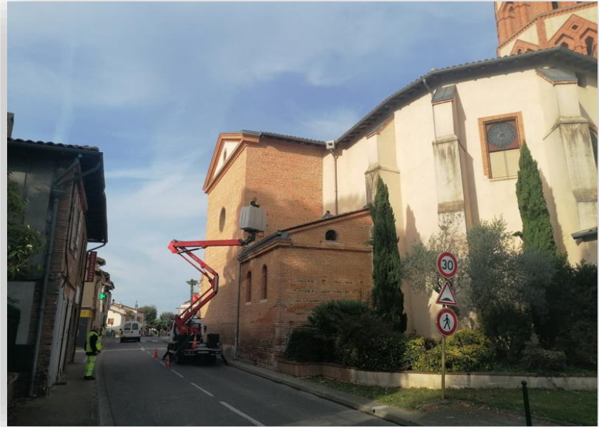
Nettoyage des chéneaux
