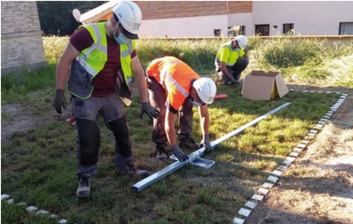
Installation de la place handicapée devant la chapelle.
