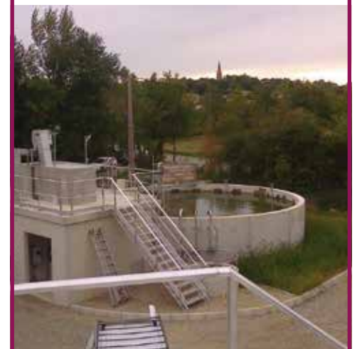
2016 : Nouvelle station d'épuration
