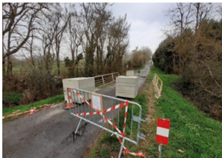
Route barrée au pont d'en Caillaouet
