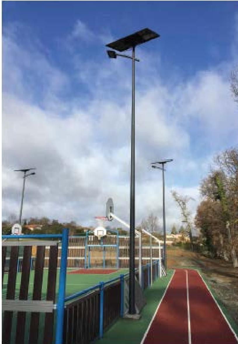
Le lampadaire solaire est idéal pour l'éclairage des parkings, lotissements, parcs, jardins publics, voies vertes, comme ici pour le City stade de Sainte-Foy-de-Peyrolières.
