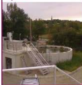
2016 : Nouvelle station d'épuration
