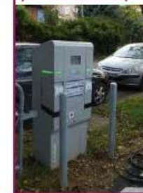
2018 : Borne de recharge pour véhicules électriques
