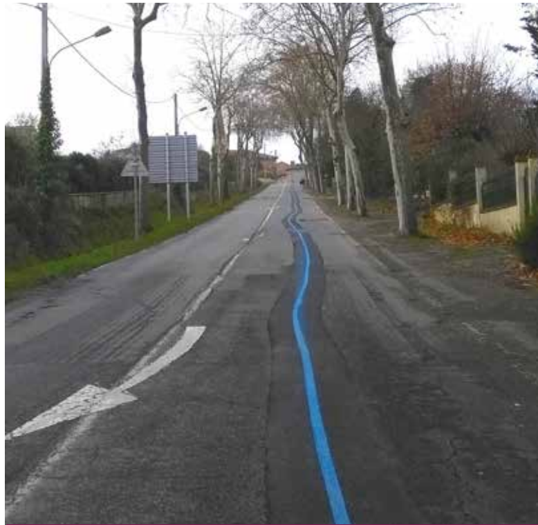
La fibre optique se cache 40 cm sous la « vilaine » ligne bleue - Avenue du 19 mars - en montant vers le centre du village.
